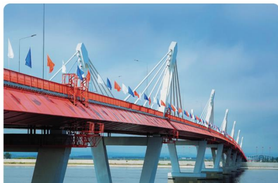
阿穆尔河（黑龙江）跨境公路大桥
