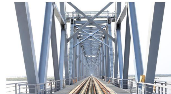
加林达(俄罗斯) - 漠河(中国) 铁路桥工程
