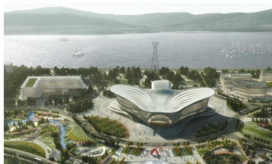
中方跨境索道客运站
